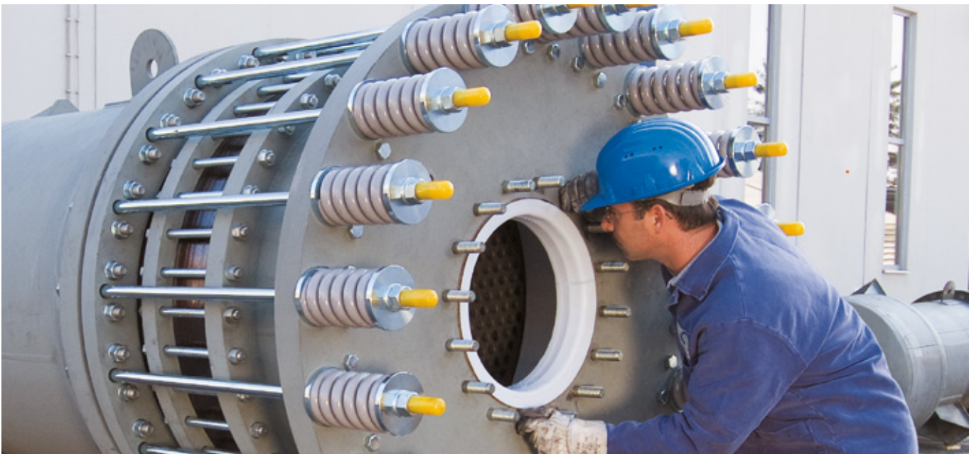
↑ Inspektion eines SGL Carbon Apparates
