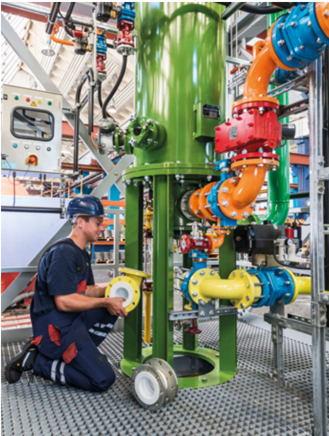
↑ Installation einer HCl Synthese
